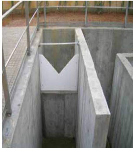
Figura 29. Vertedero triangular.
