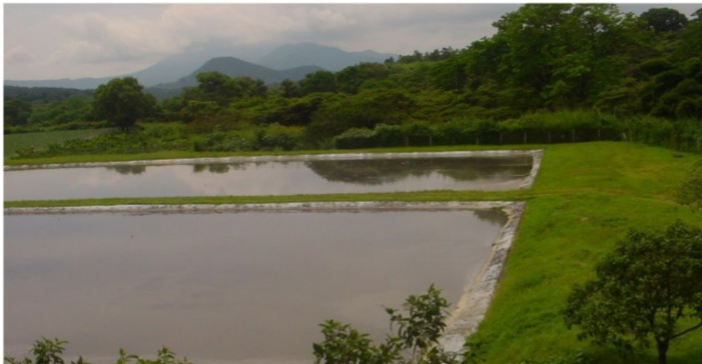
Figura 50. Lagunas anaeróbicas (4 m de profundidad), Boca del Monte, Guatemala.
