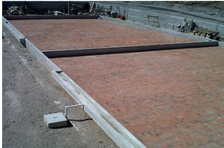
Figura 70. Patio de secado de lodos, PTAR Los Cebollales I, Panajachel, Sololá.
