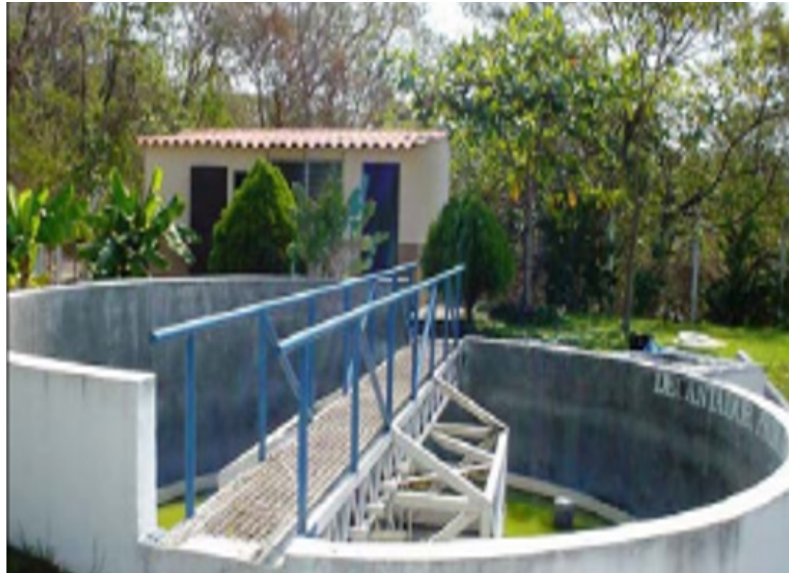
Figura 34. Sedimentador Circular Primario Dortmund.
