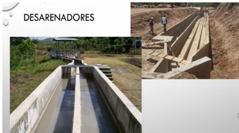
Figura 26. Desarenadores contruidos en paralelo, uno en operación y el otro en mantenimiento.
