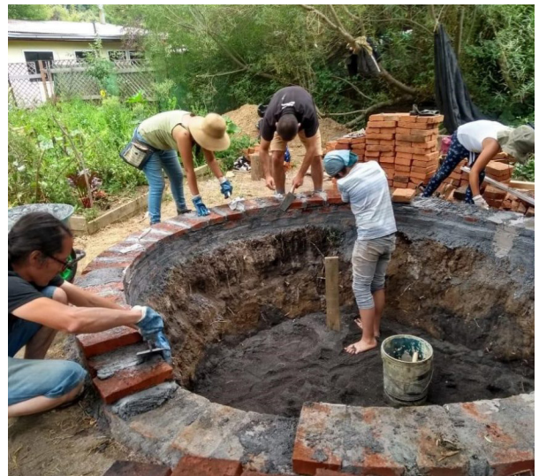
Figura 16. Instalación de lombrifiltro.
