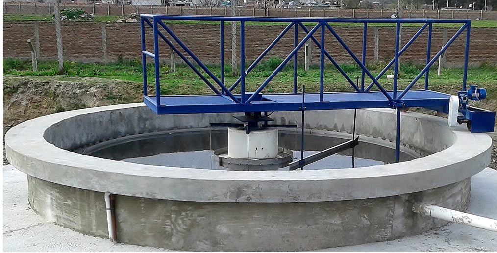
Figura 36. Sedimentador Circular Secundario Dortmund.
