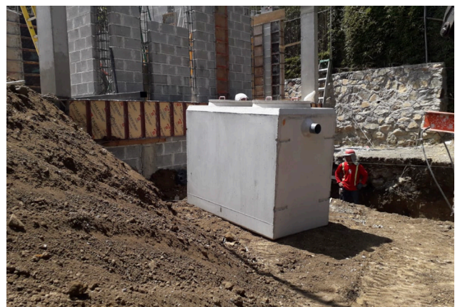
Figura 4. Trampa de grasa rectangular.
