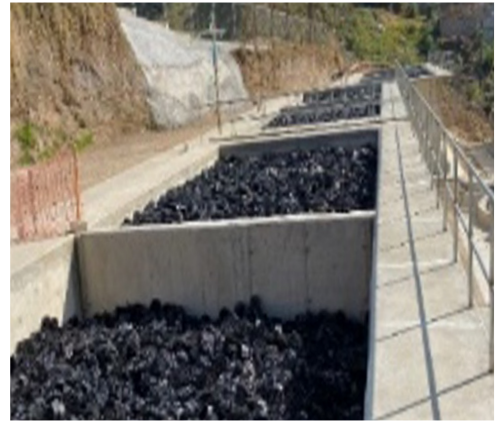
Figura 44. Filtros percoladores de PTAR.
