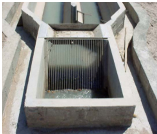
Figura 24. Canal de rejillas en funcionamiento.
