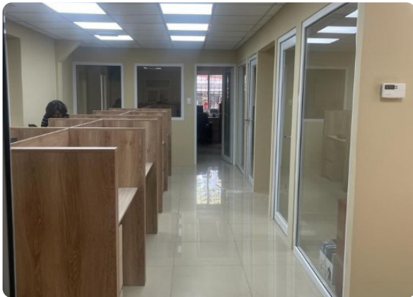
Readecuación y remozamiento de la Dirección de Recursos Humanos.
