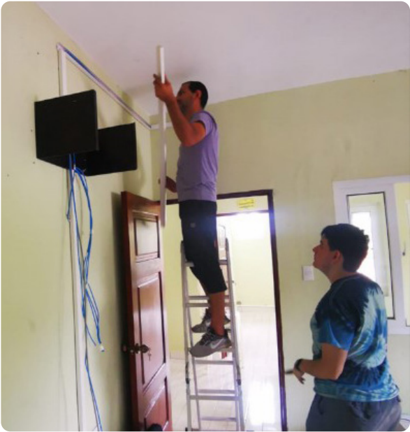
Instalación de cableado estructurado en cambio de sede con 8 puntos de red.
