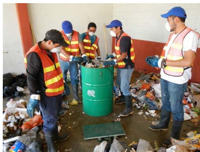
Fotografía 10 y 11. Se identifican dos momentos en la separación de los residuos; en la primera se separan los residuos de mayor volumen y cantidad; en el segundo se barren los residuos más pequeños y se colocan sobre el cernidor donde se requiere una mayor precisión y análisis. Estudio de caracterización en el municipio de Quetzaltenango, por el MARN. Fotografía: Melissa Alvarez, 2014.
