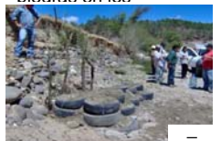
Foto 5. Sobre las llantas "cimiento" se
